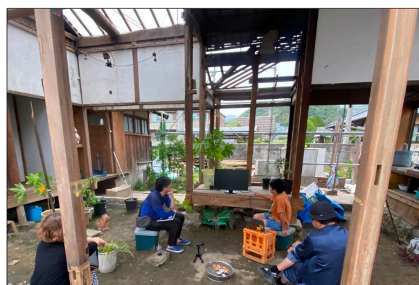
解体中の古民家 (2023年)
